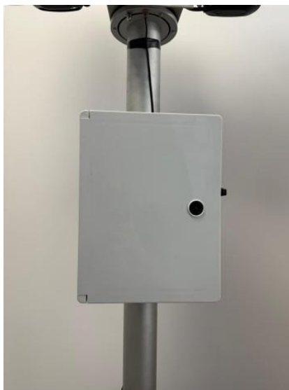
Korrekt montering av kopplingslådan
