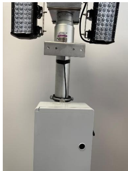
Fissaggio corretto della scatola di giunzione
