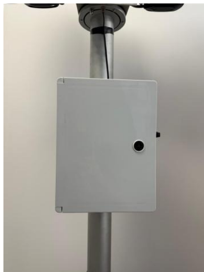
Fissaggio corretto della scatola di giunzione
