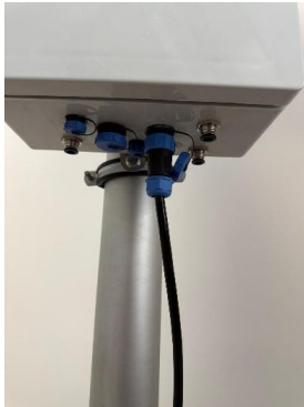
Collegamento alla torre
