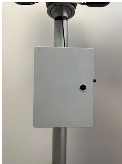
Fixation correcte de la boîte de jonction
