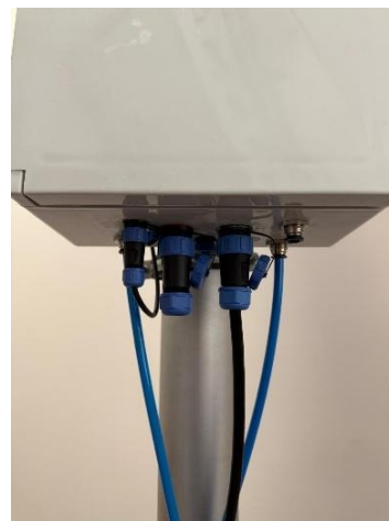
Raccordement à l'entrée d'air du mât
