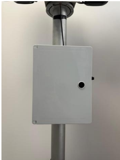
Korrekt montering af samledåsen
